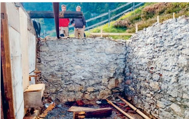
Das Mauerwerk muss stabilisiert und mit dem Keller trocken gelegt werden
