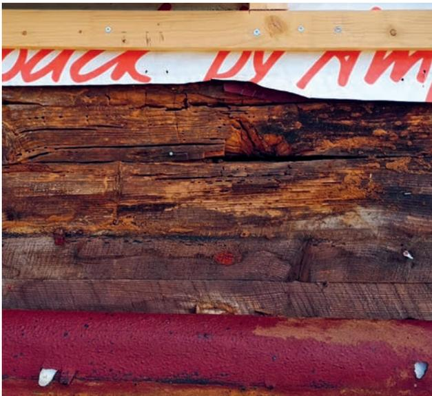
Da bei der bestehenden Einkleidung die Hinterlüftung fehlte, entschieden wir uns für eine Erneuerung.
