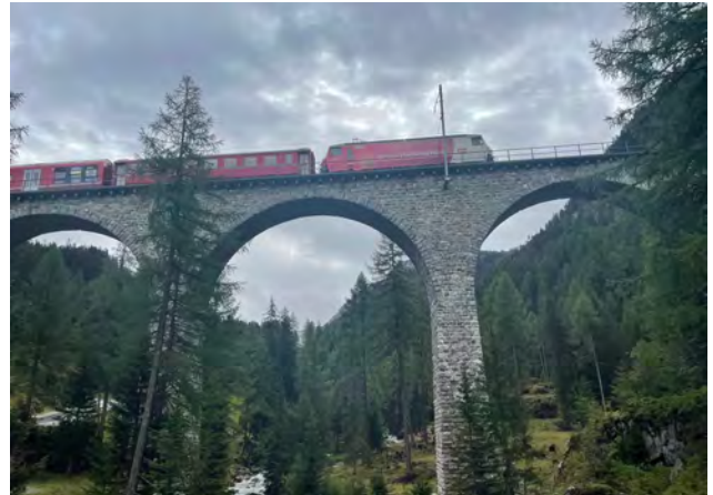
Eindrückliches Viadukt auf der Albulastrecke
