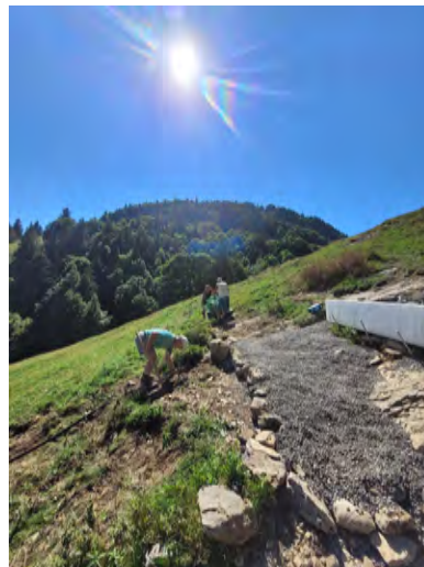
Extreme Bedingungen bei der Installation des neuen Brunnens
